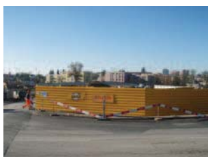
Oplocení na staveništi
